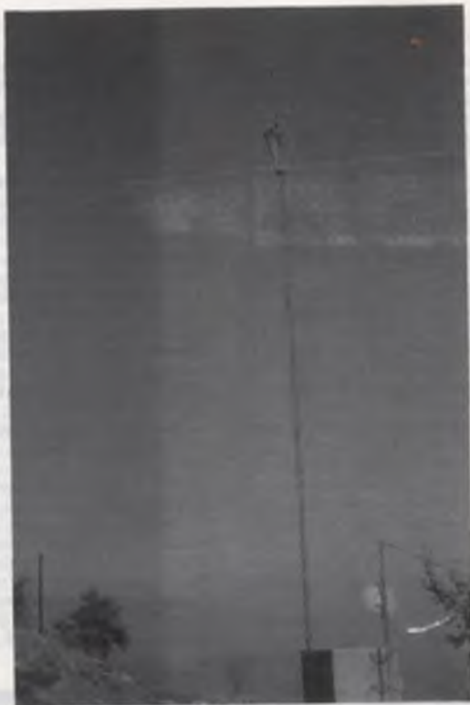
Τοποθέτηση διπόλων για τον αναμεταδότη R4
