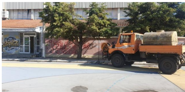
Καθαρισμός φρεατίων στο κλειστό γυμναστήριο Νάουσας
